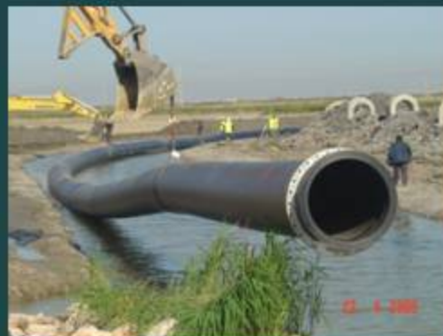
Introducir en la zanja
