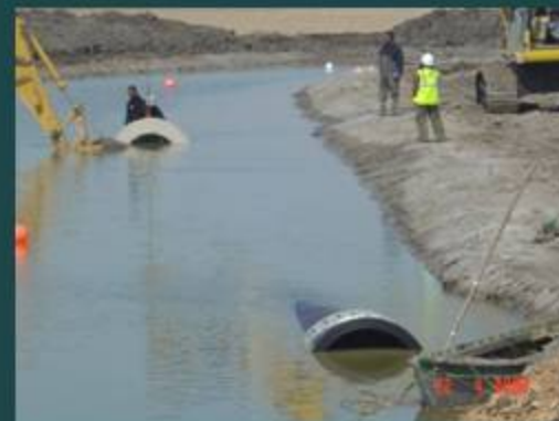
Hundir la tubería
