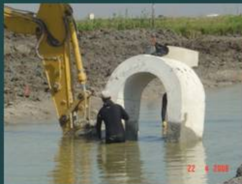
Colocar los en la tubería
