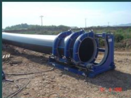
Soldar a tope fuera de la zanja
