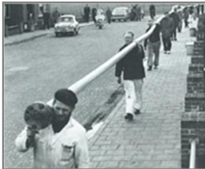
Demostración de la extrusión de tuberías plásticas a finales de los 50
